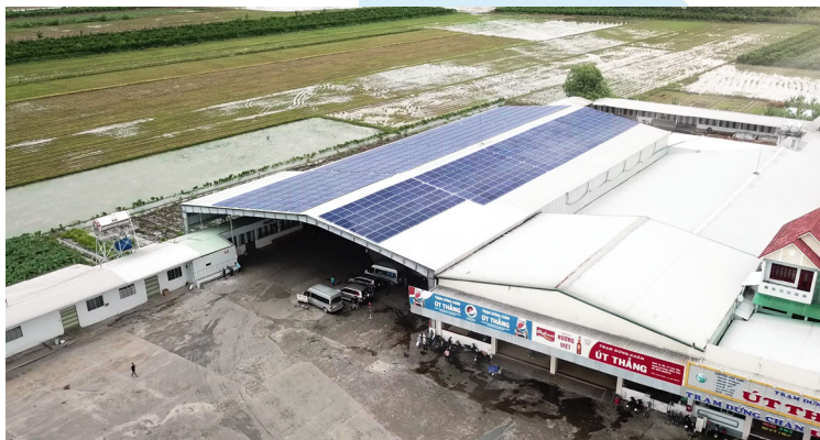
Trạm Dừng Chân Út Thẳng - Công suất 300 kWp
