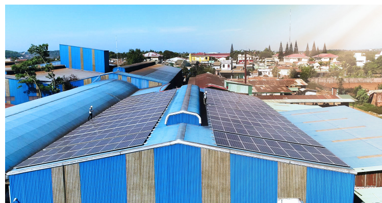
Công Ty TNHH XNK Hoa Trang - Công suất 103 kWp
