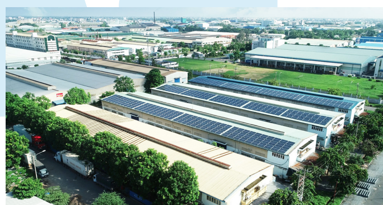
Nhà Máy Parapex - Công suất 240 kWp
