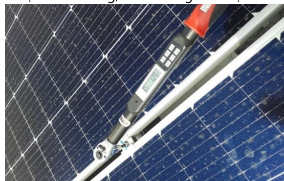
Kiểm tra lực siết kẹp giữ tấm pin
