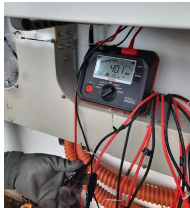
Kiểm tra điện trở cách điện chuỗi pin
