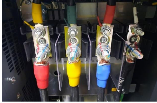
Kiểm tra lực siết tại vị trí kết nối cáp AC của inverter và đánh dấu lại vị trí
