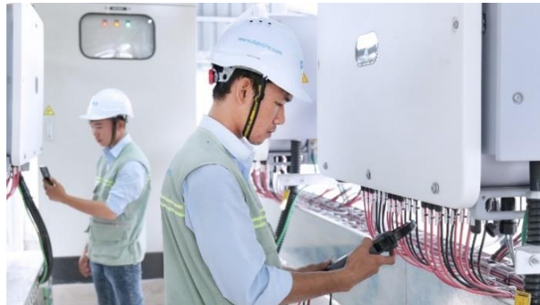
Kiểm tra dòng điện DC bằng Ampe kim
