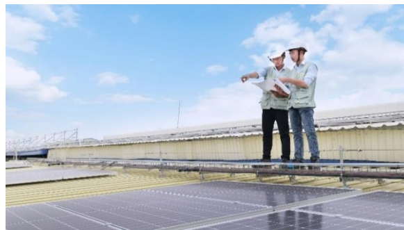
Kiểm tra lắp đặt các tấm pin
