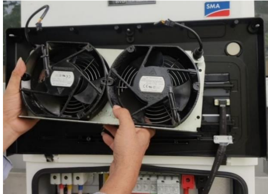
Vệ sinh quạt tản nhiệt của inverter
