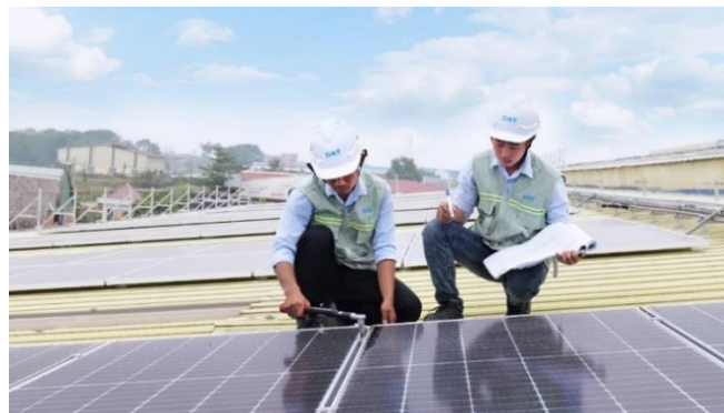
Kiểm tra lực siết của kẹp tấm pin bằng cờ lê lực
