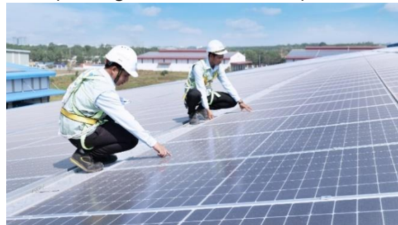
Kiểm tra bề mặt các tấm pin
