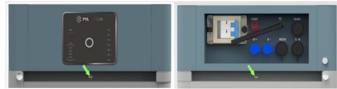
Cố định BMS và Module bằng các thanh đỡ và bulong
