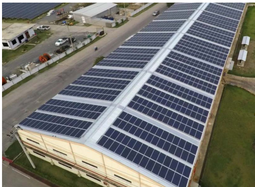
Các tấm pin được bố trí thành dãy 2 tấm, phù hợp cho việc lắp đặt và vận hành
