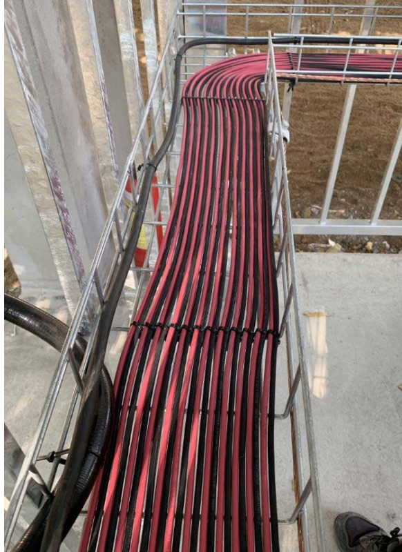
Dây dẫn được cố định theo từng lớp
