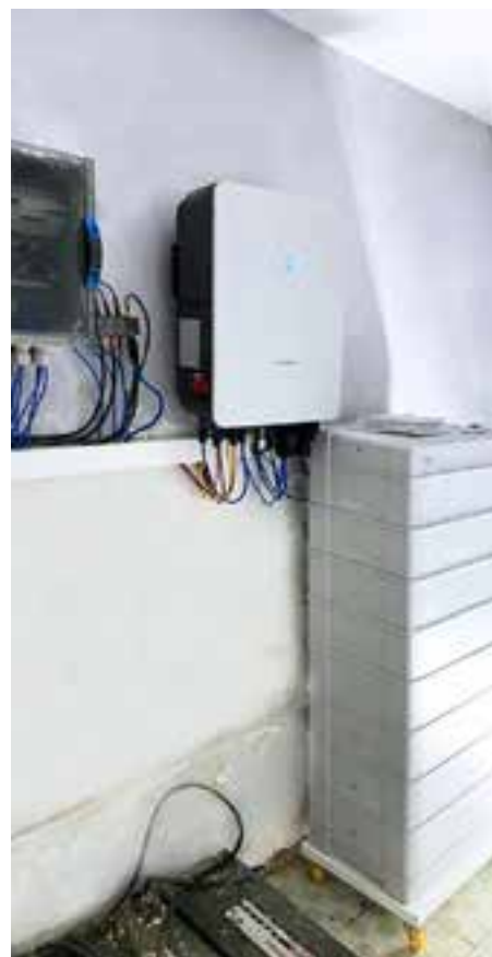
Hệ thống Hybrid Sungrow 10kW 3 pha Battery Sungrow SBR 25,6kWh
