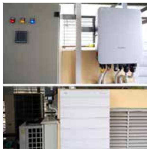
Hệ thống điện mặt trời kết hợp lưu trữ điện Hybrid 25,6kWh Lắp đặt tại: Biệt thự BT19 KĐT Nam Cường, Bắc Từ Liêm, Hà Nội Thời gian hoàn thành: T7/2021
