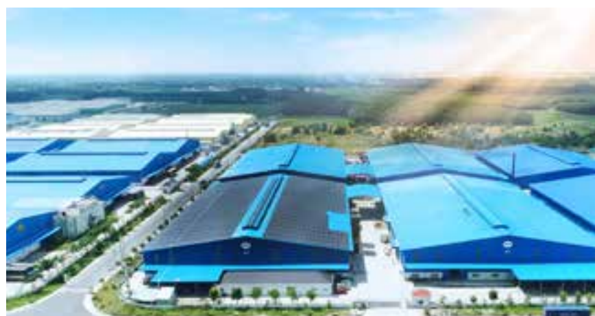
Dự án Công ty gỗ Xuân Mạnh, Bình Dương Công suất: 997kWp
