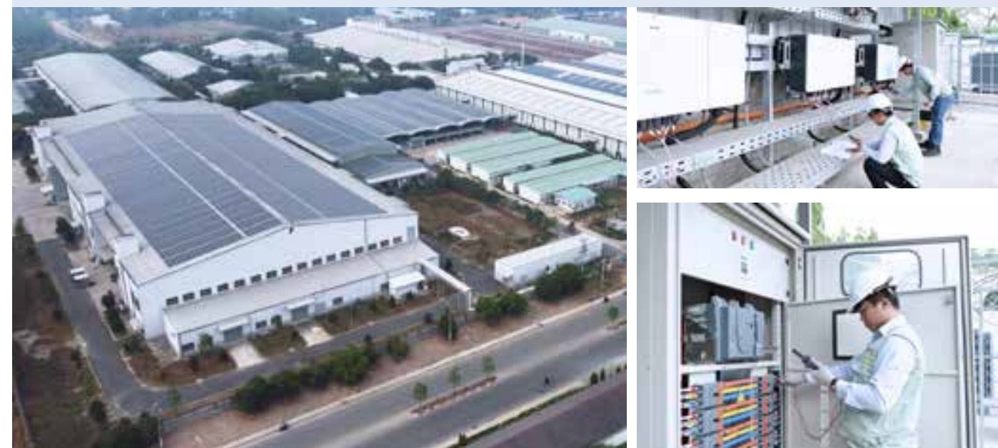
Tại Nhà máy giày Đại Lộc, KCN Rạch Bắp, Bình Dương Công suất: 1MWp Ngày hoàn thành: T1/2021
