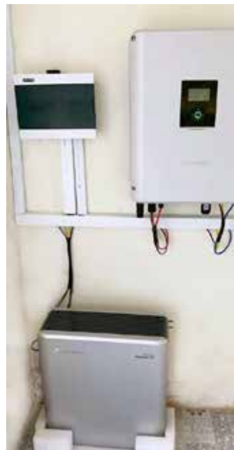
Hệ thống Hybrid Sungrow 5kW 1 pha Battery Sungrow SBP 4,8kWh
